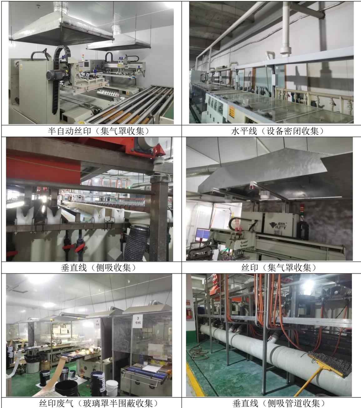
图 2.14-25 现有项目废气收集现状照片
