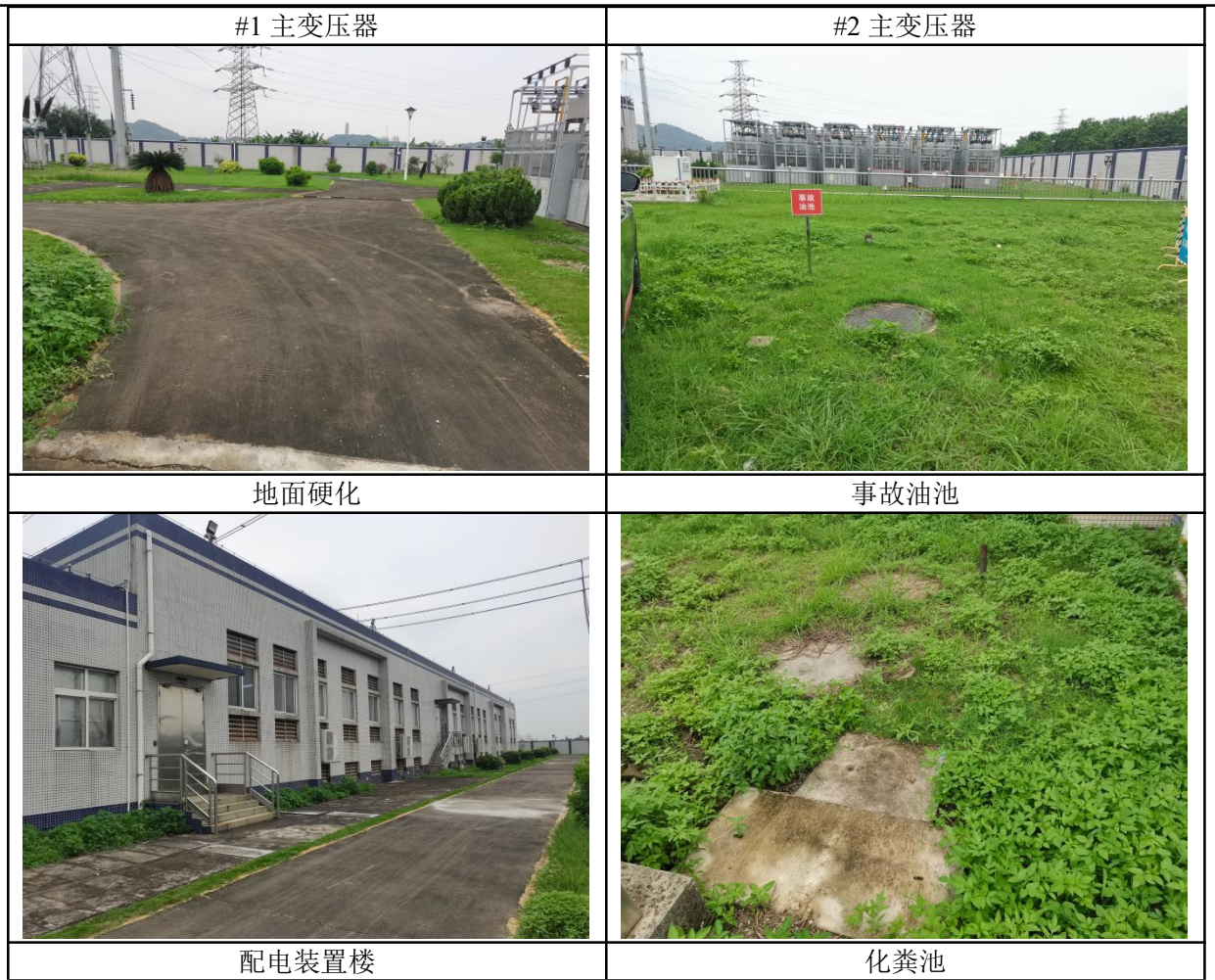
图 3-5 220kV 德隆站现状照片
