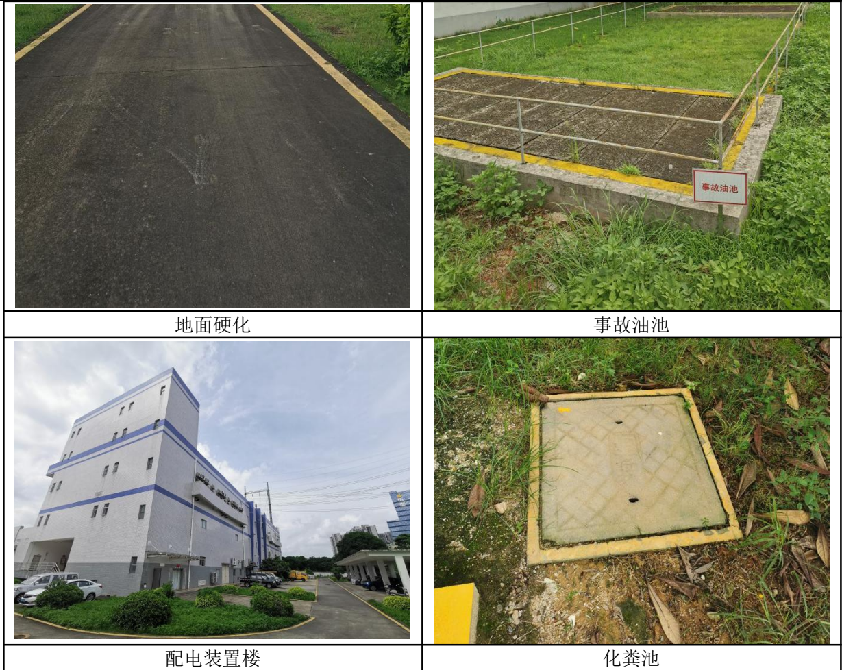
图 3-5 220kV 中山站现状照片
