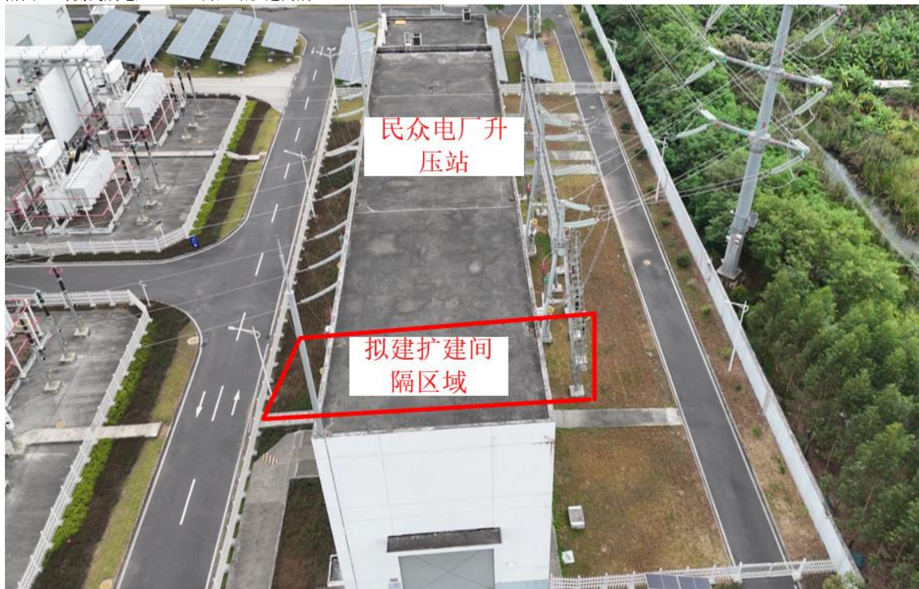
附图 5 对侧民众电厂 220kV 升压站扩建间隔
