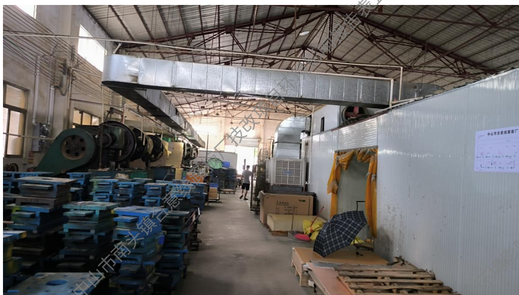
图 3-2 厂区地面现状
