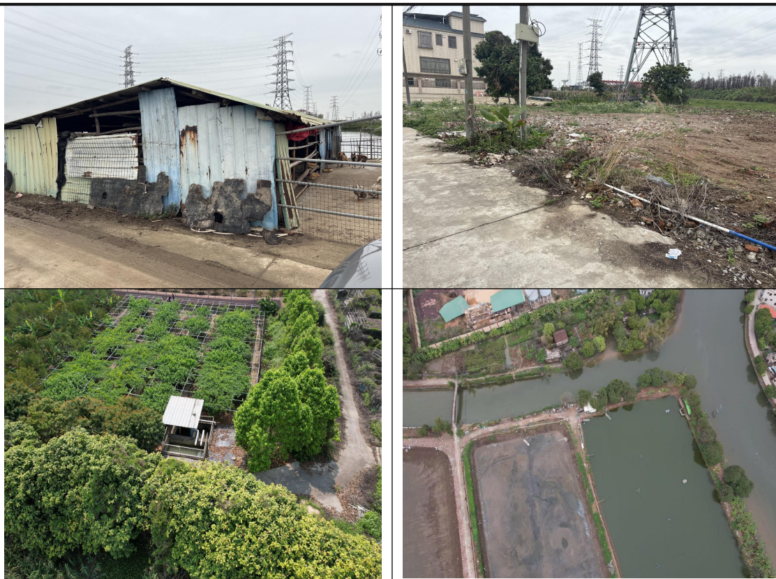
拟建输电线路沿线现状
