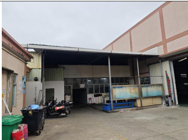
项目西面厂区食堂
