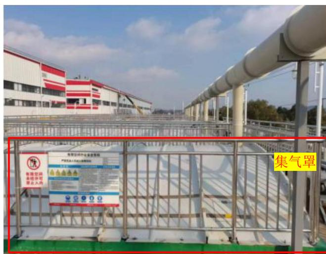
**图 4-2 污水处理站废气收集方式示意图**
