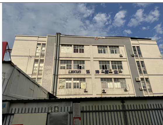
项目南侧-中山市乐坤管业有限公司
