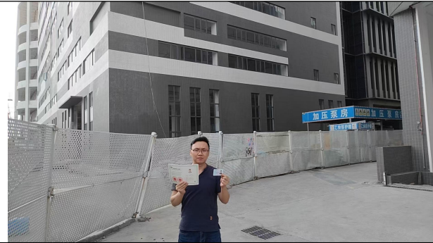
西面-D 栋厂房
