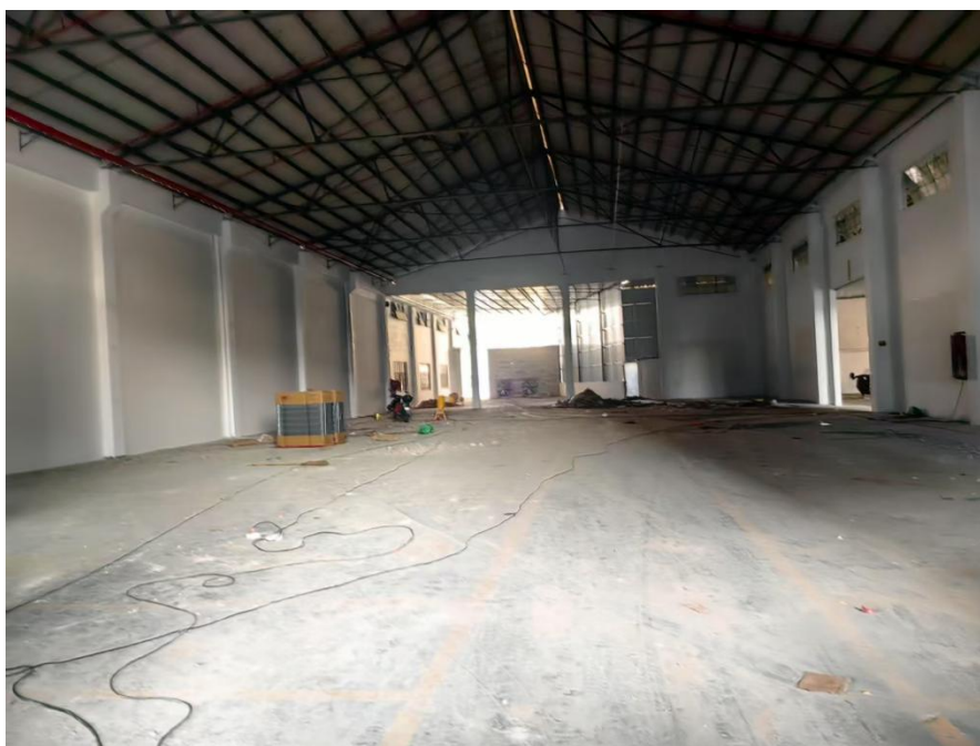
图 3-2 厂区内硬底化处理
