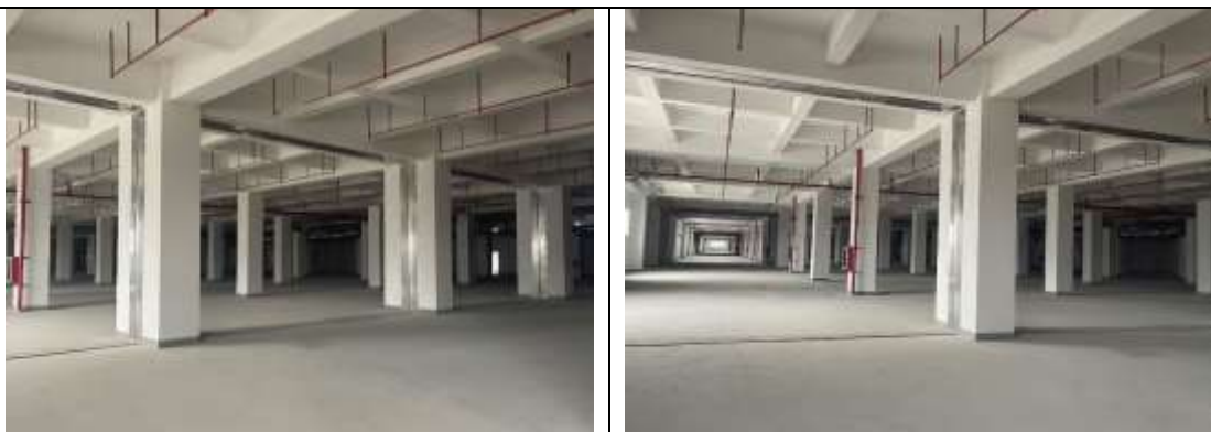
图 3-2 项目 5 号厂房内部硬底化照片
