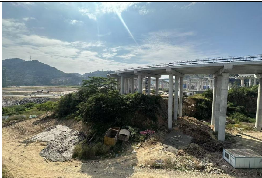
项目南面为空地、在建高速
