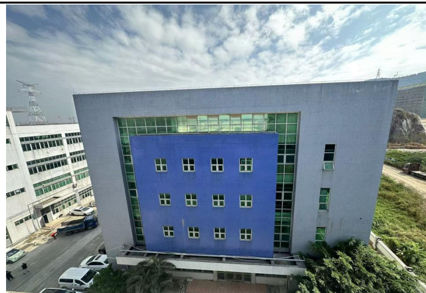
项目东面为空置厂房
