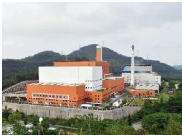
图 4.1-2 中山市中心组团垃圾焚烧发电厂
