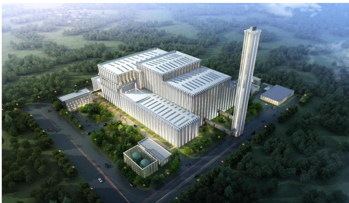
图 4.1-3 中山市北部组团垃圾焚烧发电厂
