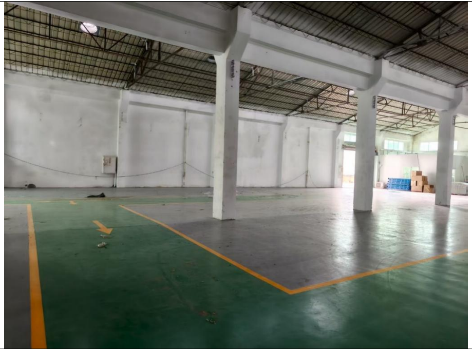
现场实际图片（厂房内）
